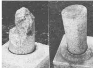
破壊された鳥居
